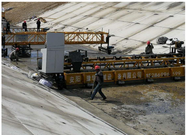
渠底衬砌施工
