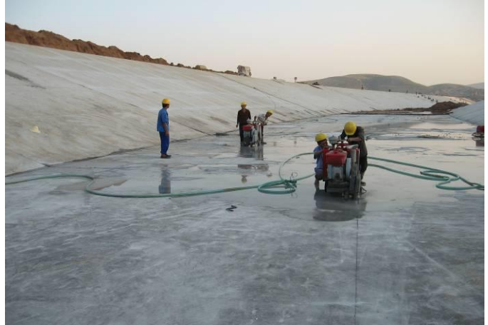
混凝土切缝
