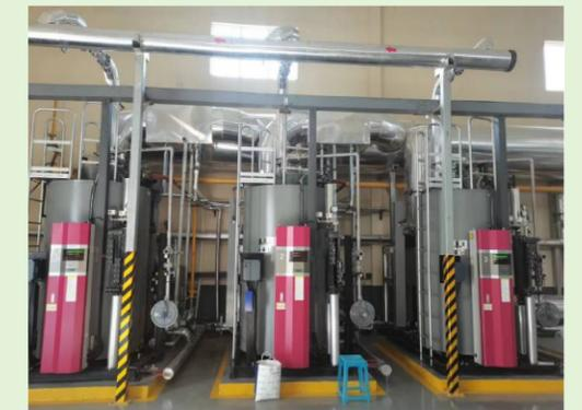
常乐制药在建设过程中针对废气治理，配备了2套袋式除尘器、1套污水处理站废气光氧催化+活性炭装置、3台低氮燃烧的天然气锅炉。所有设备正常运行保证了我公司在生产过程中产生的颗粒物、二氧化硫、氮氧化物及臭气得到深度治理并实现达标排放。
